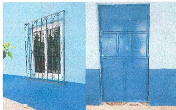
Foto 2: Así quedo la colocación de las ventanas, ventanal y puertas.
