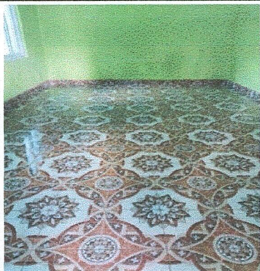
Foto 1: Así quedo la colocación de piso en las dos aulas y en la dirección
